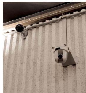
可動カメラ(右) 受発光ユニット(左) 適切な受発光ができるよう角度調節が可能
